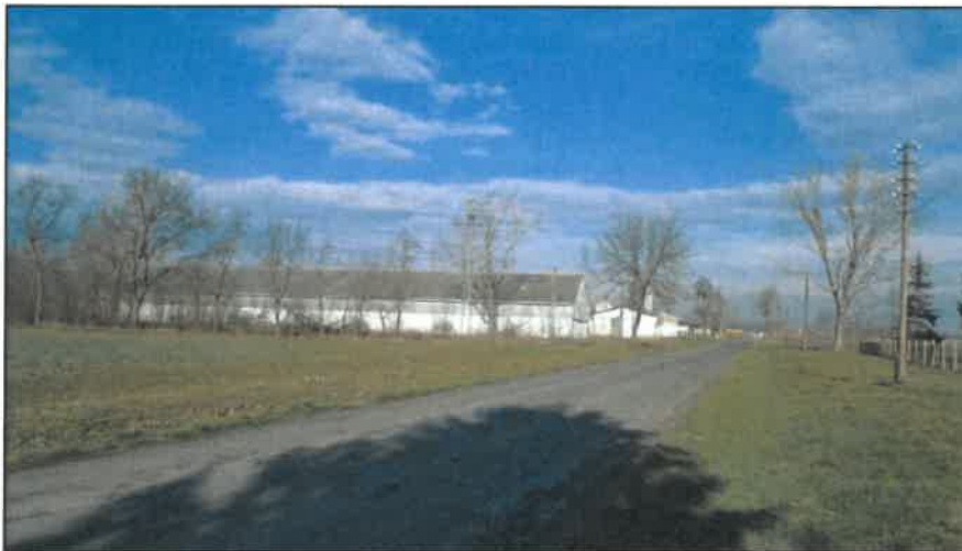
A telephelytől északnyugati irányban található mezőgazdasági telephely, takarmánykeverő üzem
