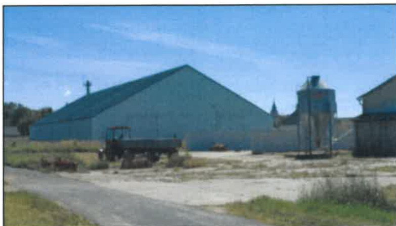
Csarnok a szomszédos területen
