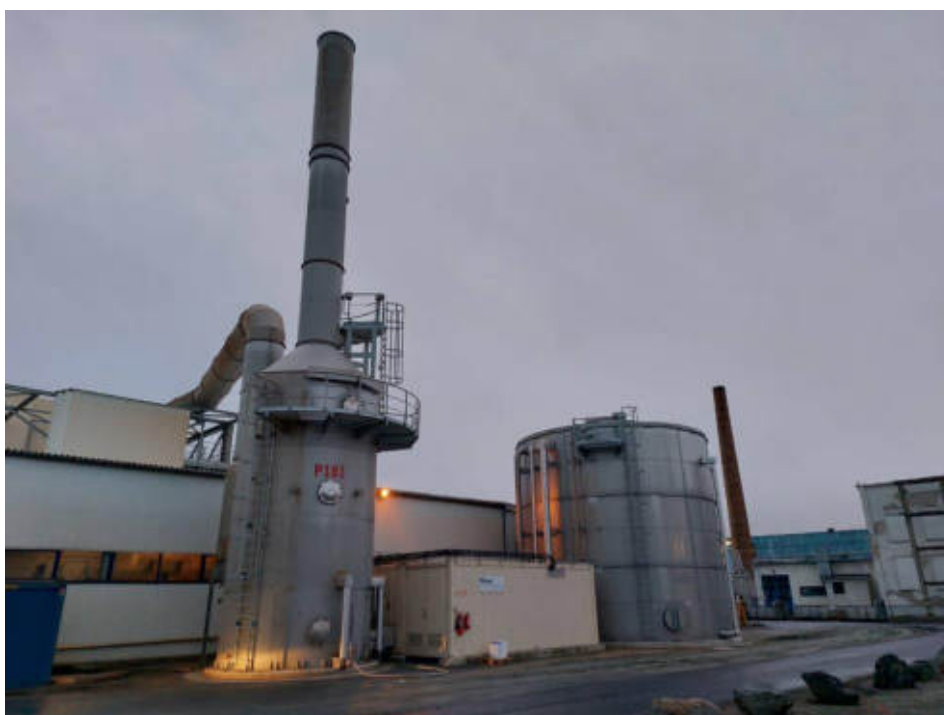
11. ábra: 2021 – Papírimpregnáló üzem formaldehyd leválasztó L205 Biofilter létesítése (P181)
