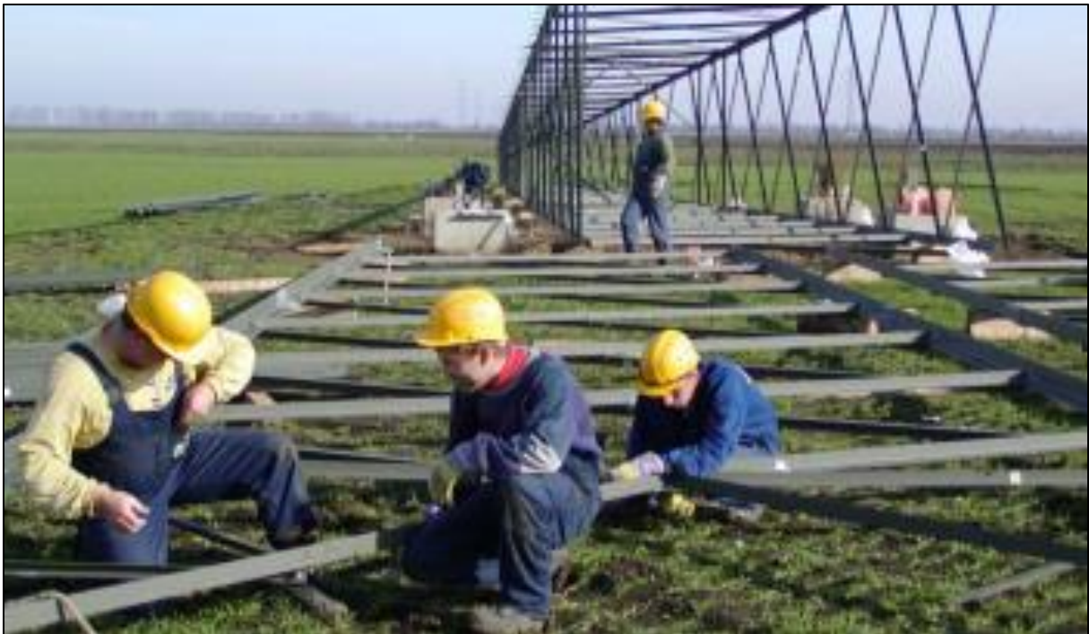
4. ÁBRA HELYSZÍNI OSZLOPSZERELÉS
