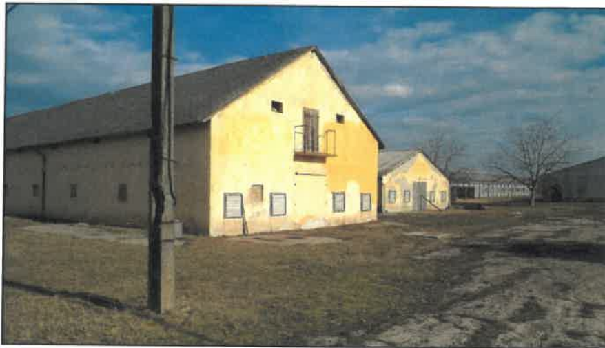
A 7.-8. számú téglá istálló ventilátorai
