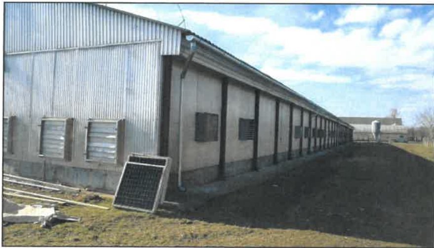
Az 1. számú istálló ventilátorai
